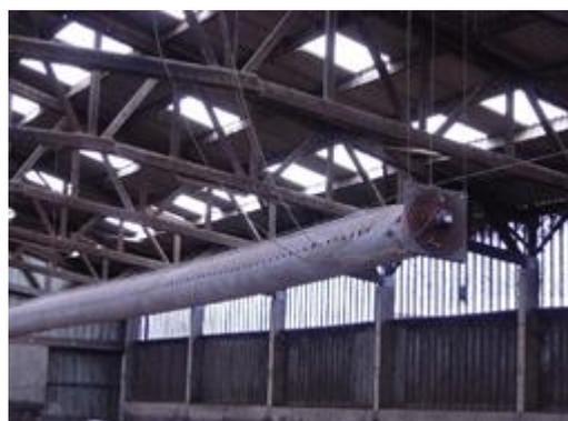
Figure M14.1. Gaine de dispersion et de mélange du gaz traceur dans le bâtiment (source : INRA)
