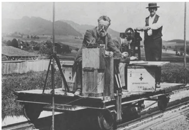
Figure 1 : Josef Epper et le premier chariot d'étalonnage de moulinets hydrométriques (1896) [Metinfo, 2012].
