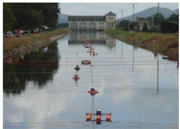
Figure 4 : Des capteurs ADCP déployés sur le canal de la Gentille (2011).
