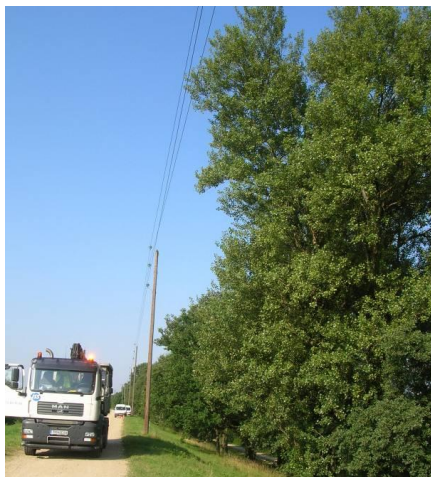
Fig. 4 Rhône canal levee, woody landside face Digue de canal du Rhône, parement aval boisé.
