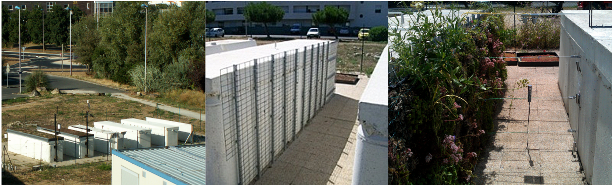
Figure 24 : Vues de la plateforme climabat et de la façade végétalisée.
