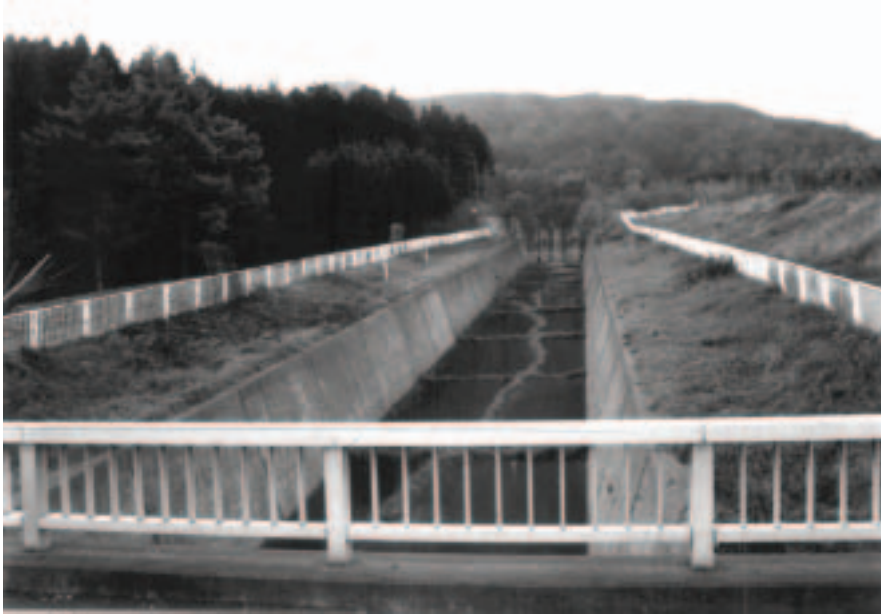
Photo 6 Ouvrage destiné à canaliser les lahars en direction du lac Toya. Vue vers l'amont (barrage filtrant et flancs boisés du volcan Usu).
