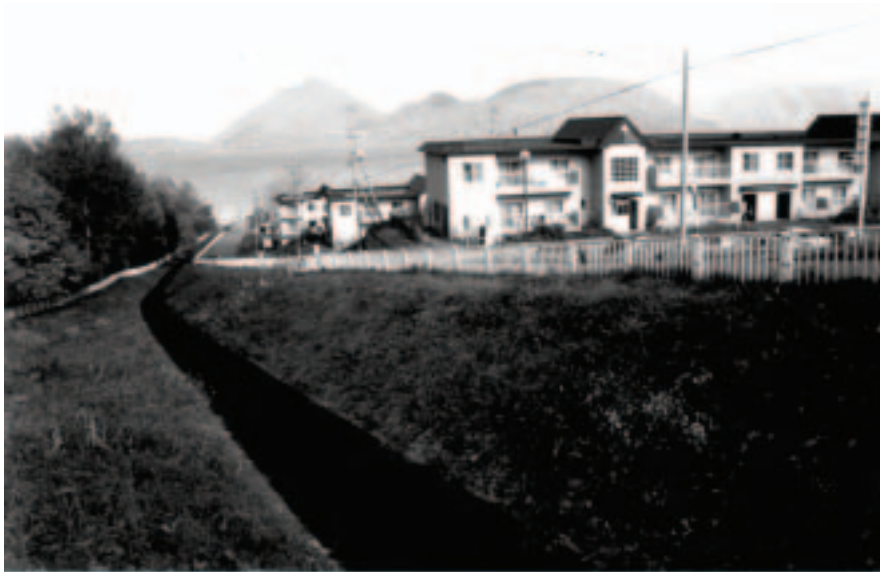
Photo 8 Canalisation construite à la suite de l'éruption de 1877-78 et destinée à contenir les lahars épurés de leurs éléments grossiers par les barrages filtrants situés en amont. L'urbanisation visible sur la photo est postérieure à cet aménagement. En arrière-plan, le lac Toya et les îles Naja-no-Shima au centre de la caldera. Municipalité de Sobetsu-Chô.
