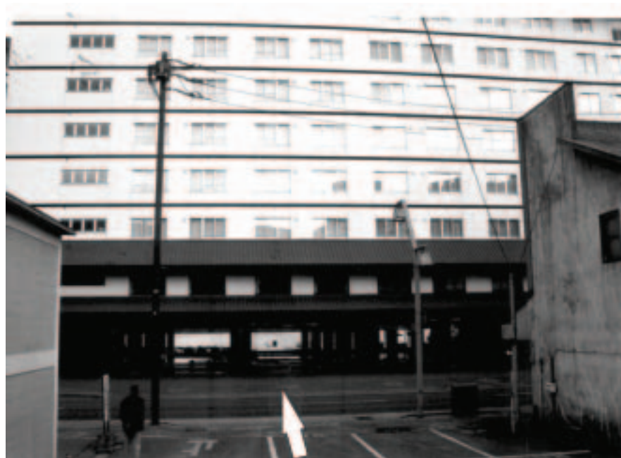
Photo 9 Grand hôtel de Toyako-Onsen dont la base est conçue pour laisser passer les lahars en direction du lac Toya. La flèche indique le sens de l'écoulement potentiel.
