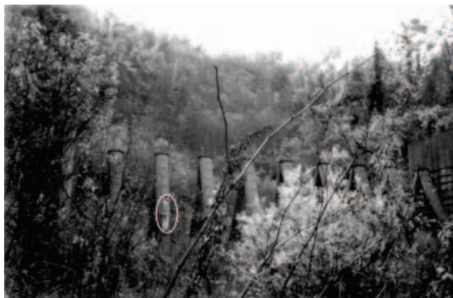
Photo 5 Barrages destinés à filtrer les éléments les plus grossiers des lahars. Plusieurs équipements de ce type sont visibles sur les flancs du volcan Usu. Le personnage cerclé donne l'échelle.
