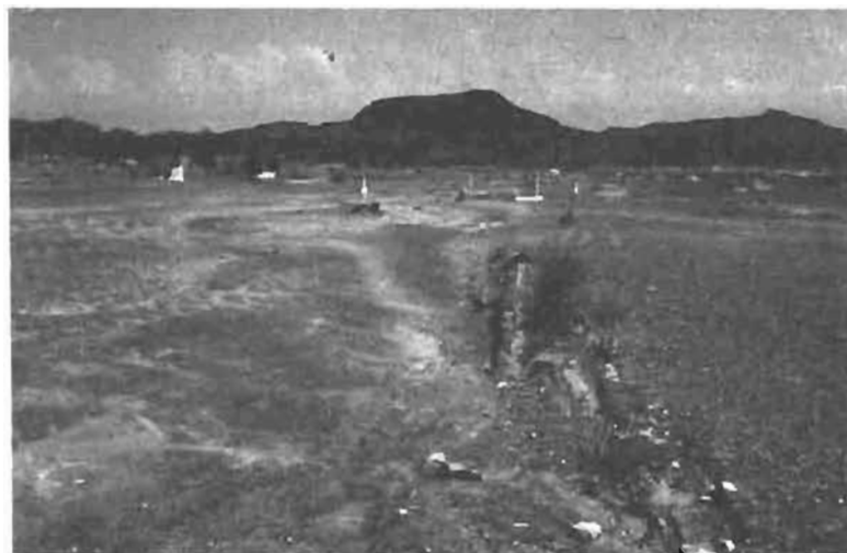
Foto 4 : Sector centro y sur de Armero afectado por flujos menos densos y más rápidos que el que se proyectó sobre la parte norte de la ciudad. Las construcciones han sido arrancadas a nivel de los cimientos.
