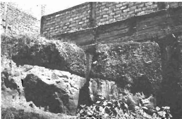
Foto 10: Latacunga: construcciones sobre depósitos laháricos (orilla izquierda del Cutuchi).
