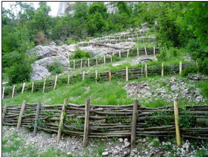
Figure 2 : Des techniques éprouvées de génie végétal (ici des fascines) fascines en l'occurrence), mais un choix d'essences pouvant être remis en question par le changement climatique (Photo F. Rey.)
