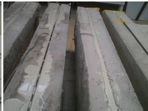
Figure 6. Mise en place de renforts et remplissage des engravures. issues des essais ont été
