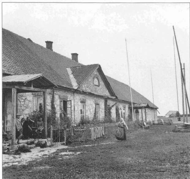
Un ancien relais de poste, sur la route de Riga à Saint Petersburg. (Coll. de Beausse)
