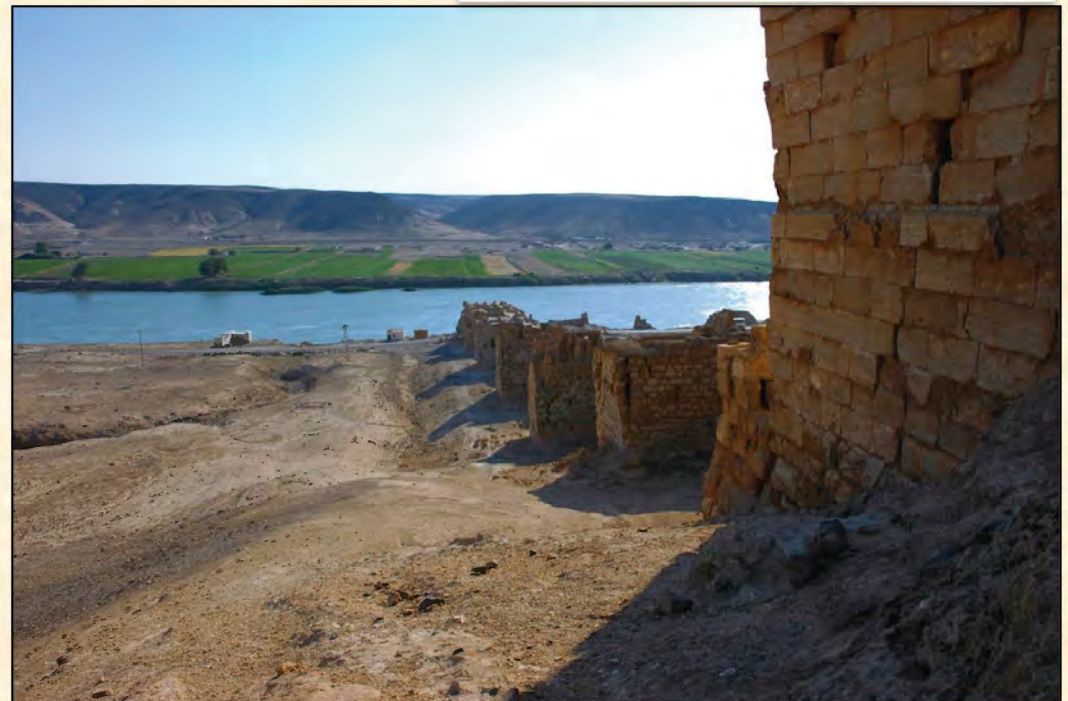
Rempart Nord, vu de l'extérieur du site
