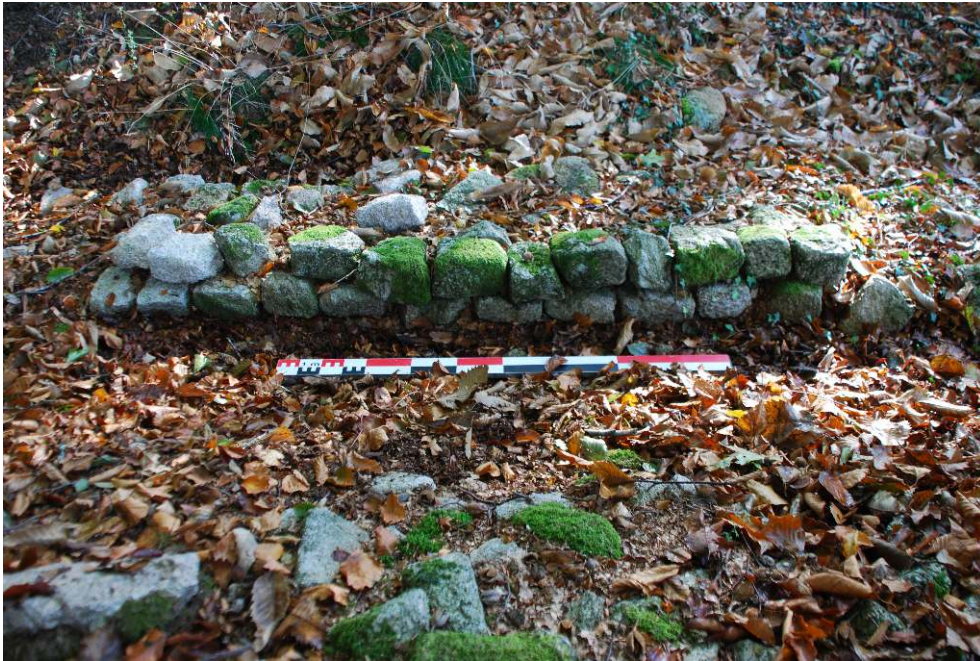
Figure 10 : Mur du sanctuaire
