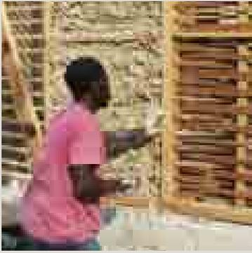
Les paysans utilisent les matériaux locaux : pierres, sable, bois, terre, pit (sisal). Ce dernier sert à la réalisation du torchis, des blocs de terre crue, des mortiers des maçonneries de pierre.
