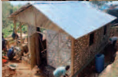
Amélioration des panneaux de clissage avec séparateurs de panneaux et tringle centrale de rigidification des gaulettes
