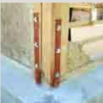
Renforcement de l'ossature bois avec des connecteurs métalliques; ici du feuillard
