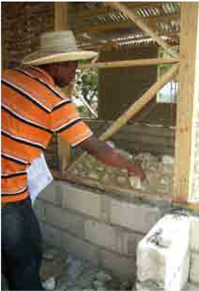
Les contremaîtres en charge de la formation des nouveaux apprentis en maçonnerie et charpente doivent être intransigeants sur la qualité : démonter pour refaire si nécessaire et répéter les gestes fait partie de la pédagogie
