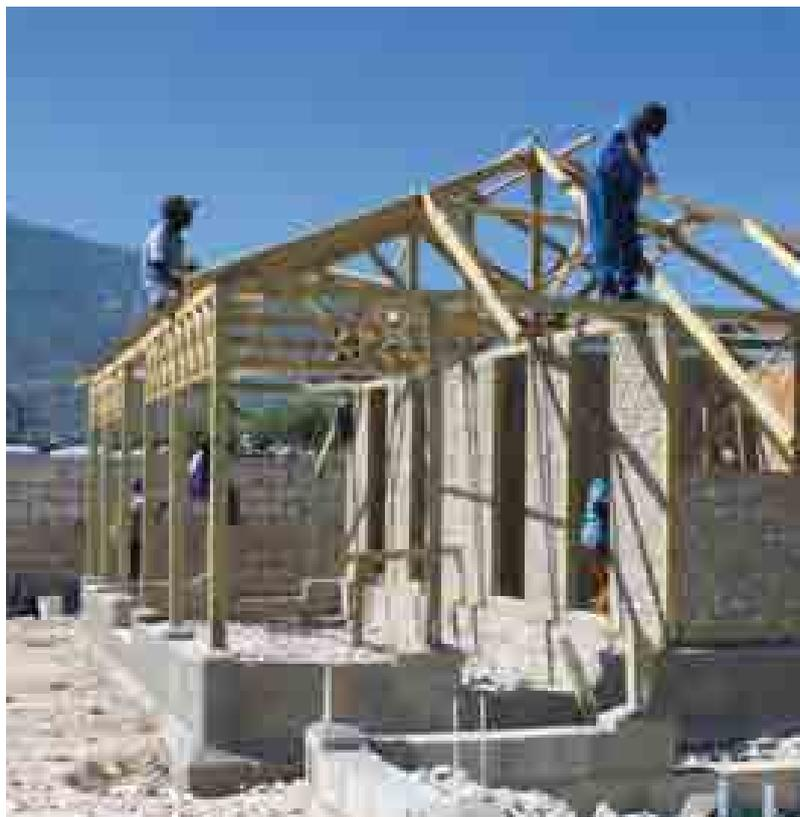
Ci-contre, remplissage en débris maçonnés des panneaux de mur en ossature bois
