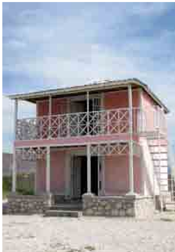
Ci-dessous, bâtiment à étage Pépinière d'entreprises, Corail Croix des Bouquets
