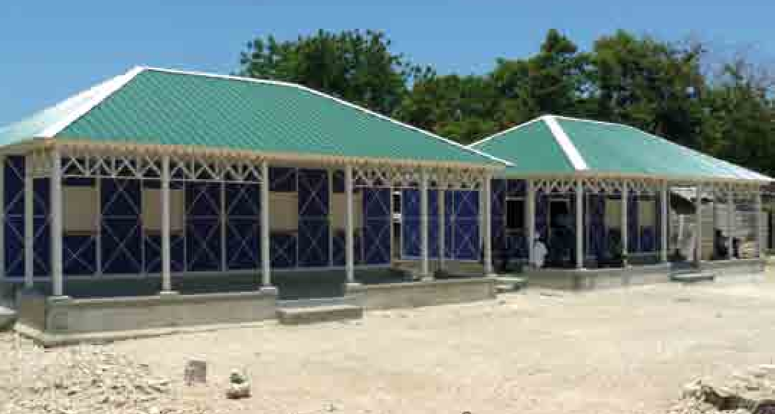
Ci-dessus et à droite, bâtiments communautaires, future gare routière, Port-au-Prince
