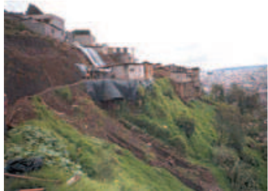
15 - Población de El Panecillo, afectada por un deslizamiento ocurrido el 18 de mayo de 2000 Foto: D. Demoraes
