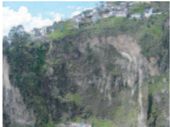
17 - Población en peligro: la localizada al borde de una antigua cantera (sector de San Roque). Foto: Dirección Metropolitana de Seguridad Ciudadana, noviembre de 2002
