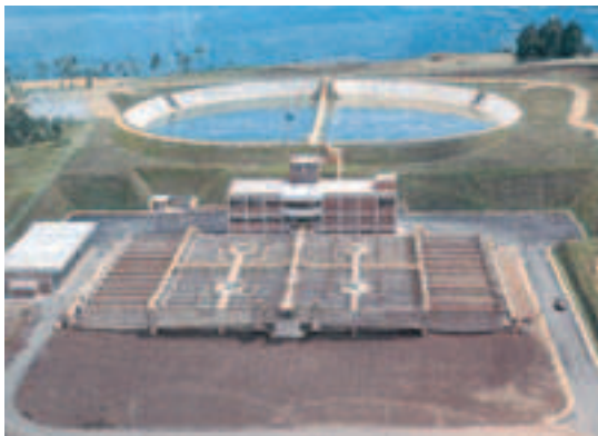
2 - La planta de tratamiento de agua de Bellavista que abastece a cerca del 40% de la ciudad de Quito.
