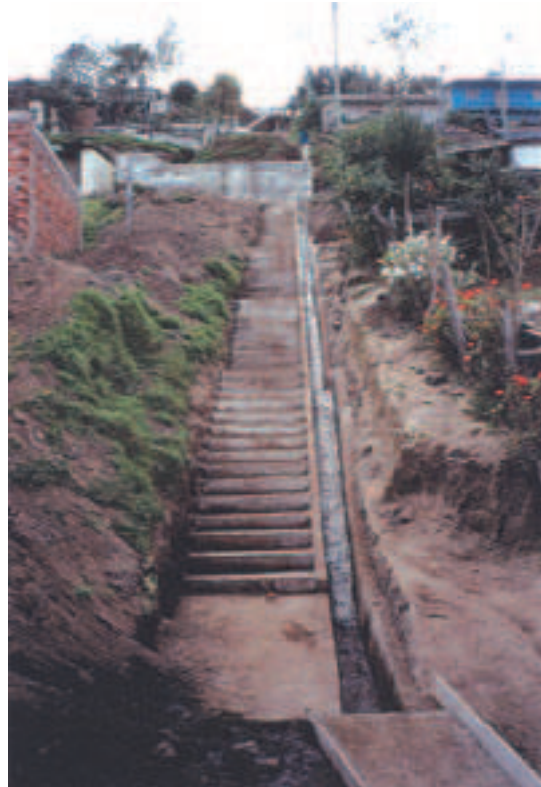
19 y 20 - Pequeñas obras destinadas a mejorar el escurrimiento en los terrenos en pendiente, realizadas en el marco de un proyecto de la ONG Cooperazione Internazionale en 2000, en el barrio Atucucho (antes y después)
