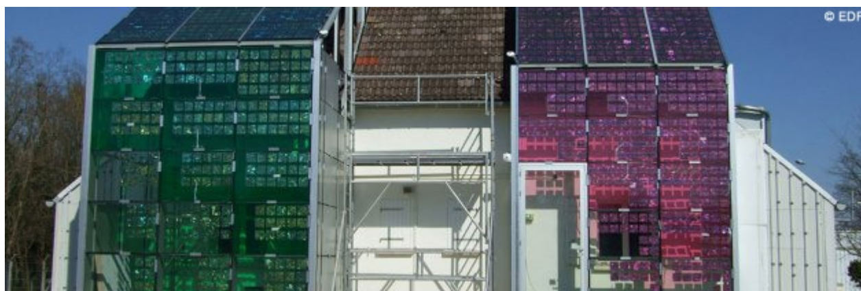
FIGURE 32 – Photographie représentant un bâtiment double-peau jouant sur la pigmentation des façades (Source : le moniteur) 124
