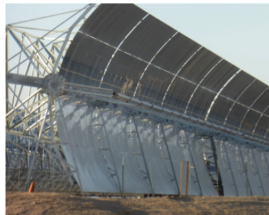
FIGURE 22 – Centrale solaire thermodynamique cylindro-parabolique (Source : Wikipedia, article sur la centrale solaire de Mojave)
