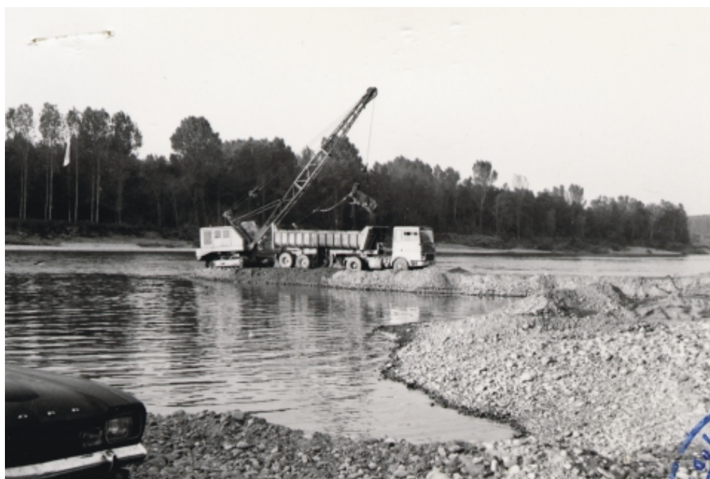
Environs de Mas Grenier en 1977 (Archives direction départementale de l'Équipement, Tarn-et-Garonne)
