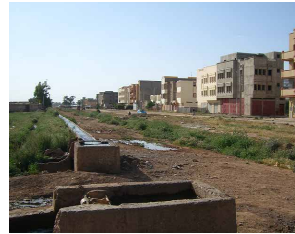
Front urbain à Fkih Ben Salah, empiétant sur le périmètre irrigué (2006)
