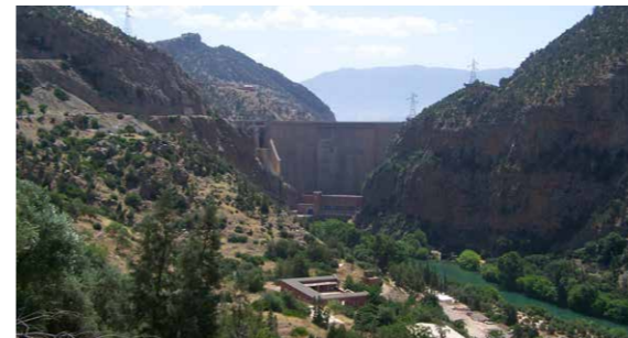
Barrage de Bin El Ouidane dans la vallée de l'oued El Abid
