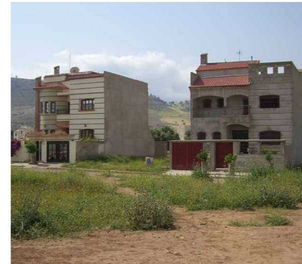
Nouveaux quartiers de villas à Beni Mellal
