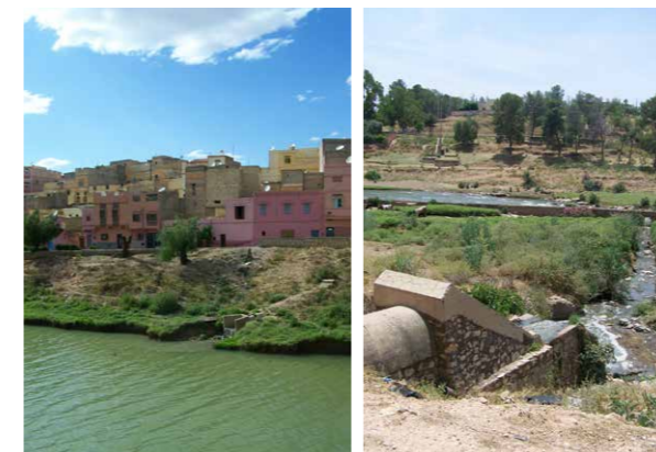
Rejets d'eaux usées domestiques directement dans l'oued Oum er Rbia à Kasba Tadla
