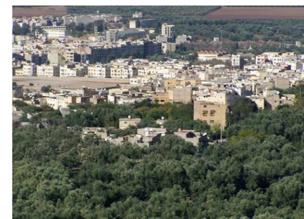
Constructions illégales au coeur de l'oliveraie non classée de Beni Mellal (2007). Noyau d'habitat spontané au 1er plan dans le quartier d'Ait Tislit (SO de Beni Mellal). 2e plan Terrain viabilisé. 3e plan une partie de la ville de Beni Mellal
