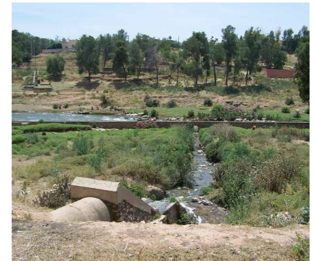
Rejet d'eaux usées directement dans l'oued Oum Rbia à Kasba Tadla
