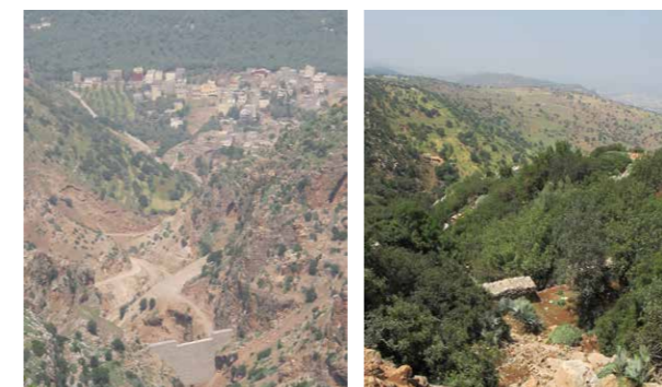
Aménagement de gabions et barrages collinaires écrêteurs de crues dans l'oued pour protéger les zones urbaines en aval
