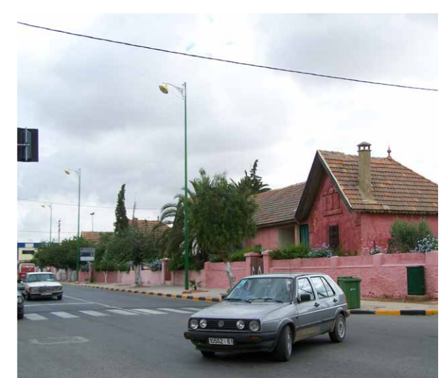
Patrimoine architectural colonial à Kasba Tadla
