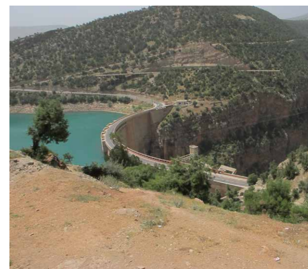
Barrage Bin El Ouidane
