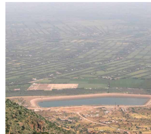
Bassin de stockage avant distribution des eaux vers le périmètre irrigué des Beni Moussa par un réseau de canaux
