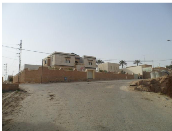
Figure 3 : rue et maison dans un quartier nouveau Guedria, Mars 2013
