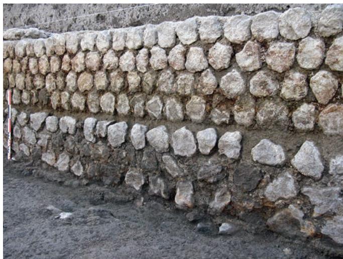
Fig. 89 – Bâtiment 4 : vue du mur ouest de l'espace A, à petit appareil « hexagonal » (clichés : G. Alfonso, Inrap).
