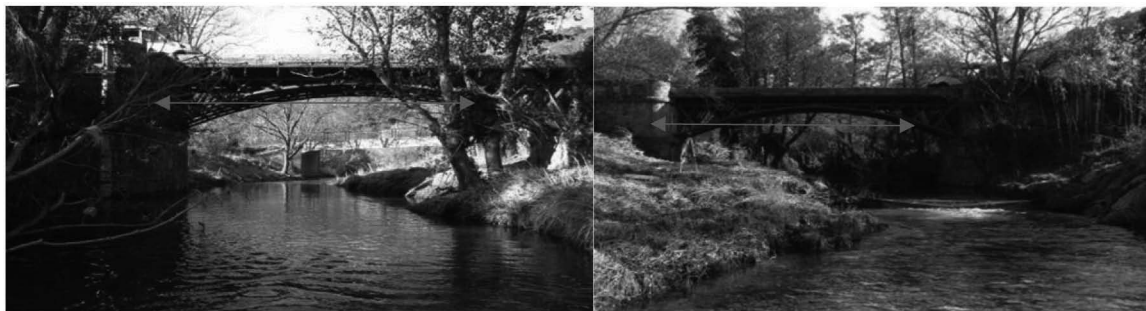
Figure 3 : Photo à gauche prise en amont du Pont de Fer ( à gauche l'échelle limnimétrique), à droite photo du Pont de Fer depuis l'aval avec le seuil. Les flèches rouges montrent la cote maximum atteinte par l'écoulement lors de la crue.
