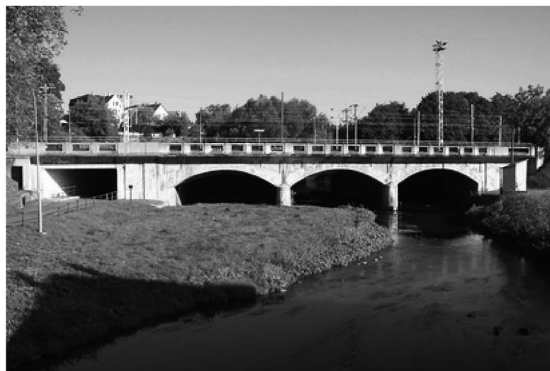
Figure 4 : Vue, à bas débit et depuis l'amont, de la station de la Sarre à Sarrebourg (code Hydro A9021010) avec au fond le pont SNCF situé en aval et au premier plan le remblai submersible situé en rive gauche
