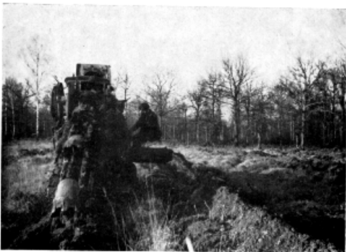
XI. Excavatrice à godets John Allen ouvrant une tranchée dans un vide. (Cl. PLAISANCE.)
