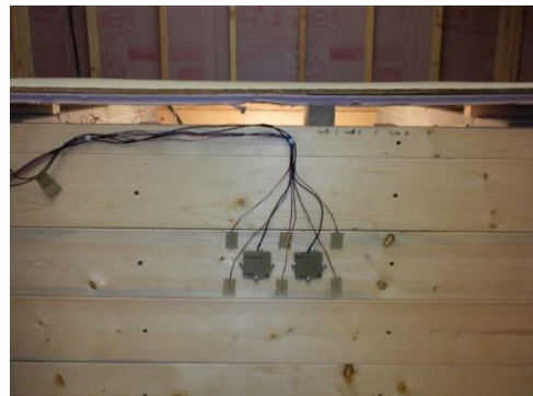
Fig. 1(b) : Vue de la paroi sud, face externe.
