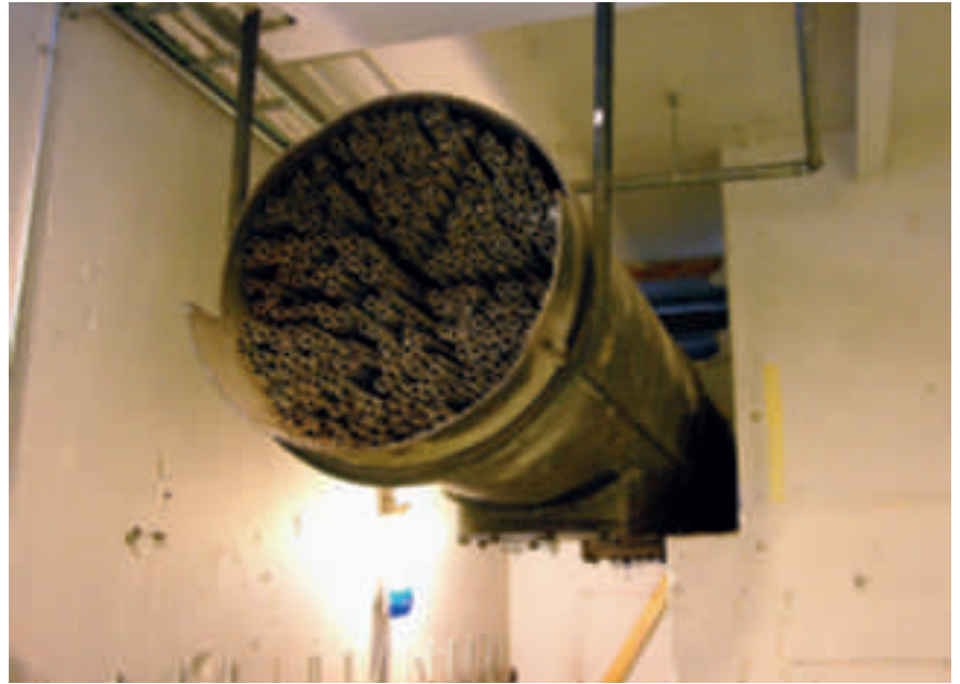
Les condenseurs. Après le passage de l'eau sous forme de vapeur, il faut la condenser avant récupération. Le condenseur droit, coupé, est présenté au public et permet de bien voir les structures tubulaires de refroidissement. Le condenseur gauche est intact mais non visitable. © Jean-Louis Kerouanton
