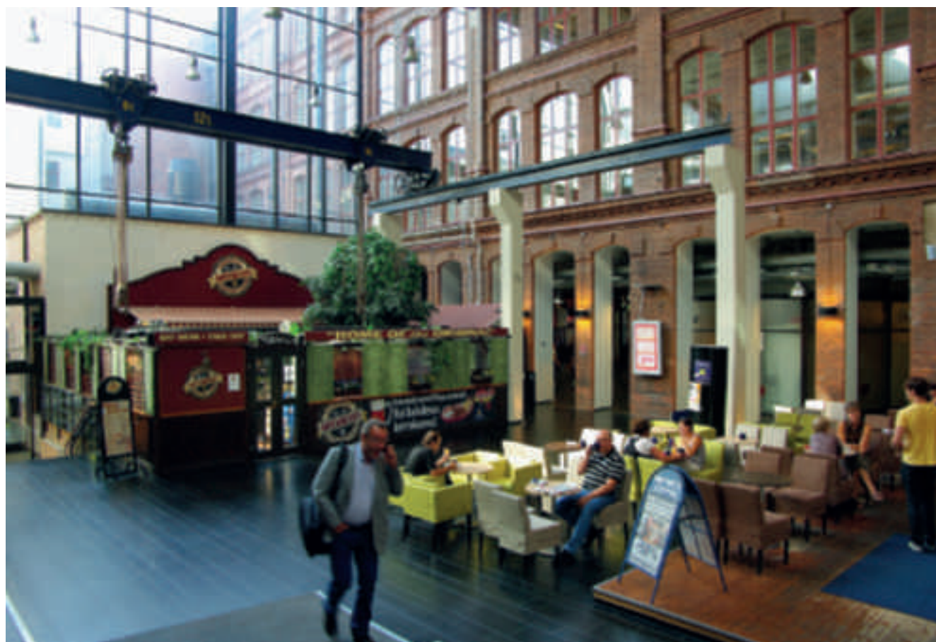
La salle des chaudières est maintenant désormais détruite ; on peut quand même y lire les anciennes manutentions aériennes, portique et pont roulant de 12t. © Jean-Louis Kerouanton
