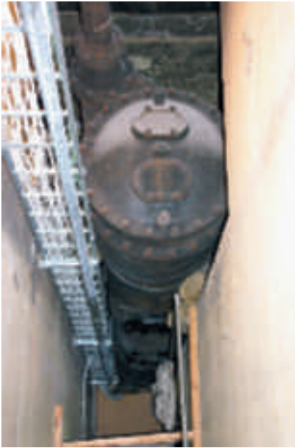
Les condenseurs. Après le passage de l'eau sous forme de vapeur, il faut la condenser avant récupération. Le condenseur droit, coupé, est présenté au public et permet de bien voir les structures tubulaires de refroidissement. Le condenseur gauche est intact mais non visitable. © Jean-Louis Kerouanton
