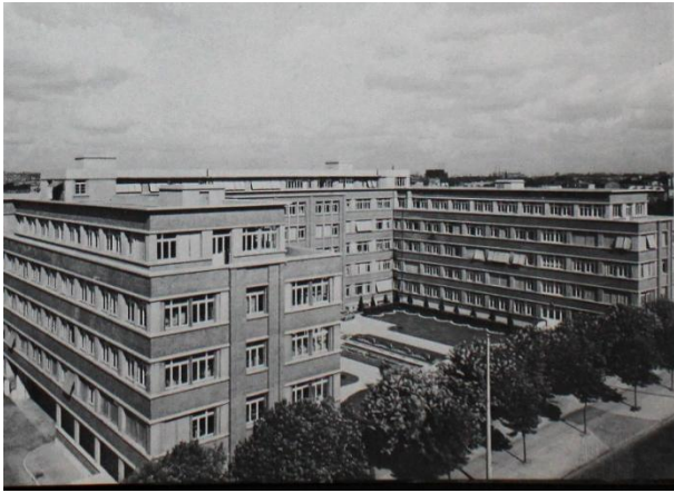
Usine de Maisons Alfort (Val de Marne)
