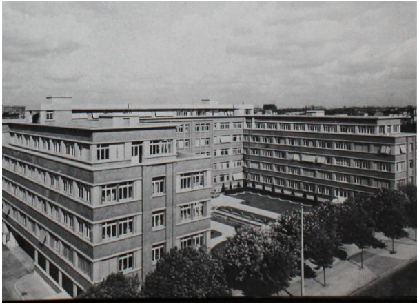
Usine de Maisons Alfort (Val de Marne)
