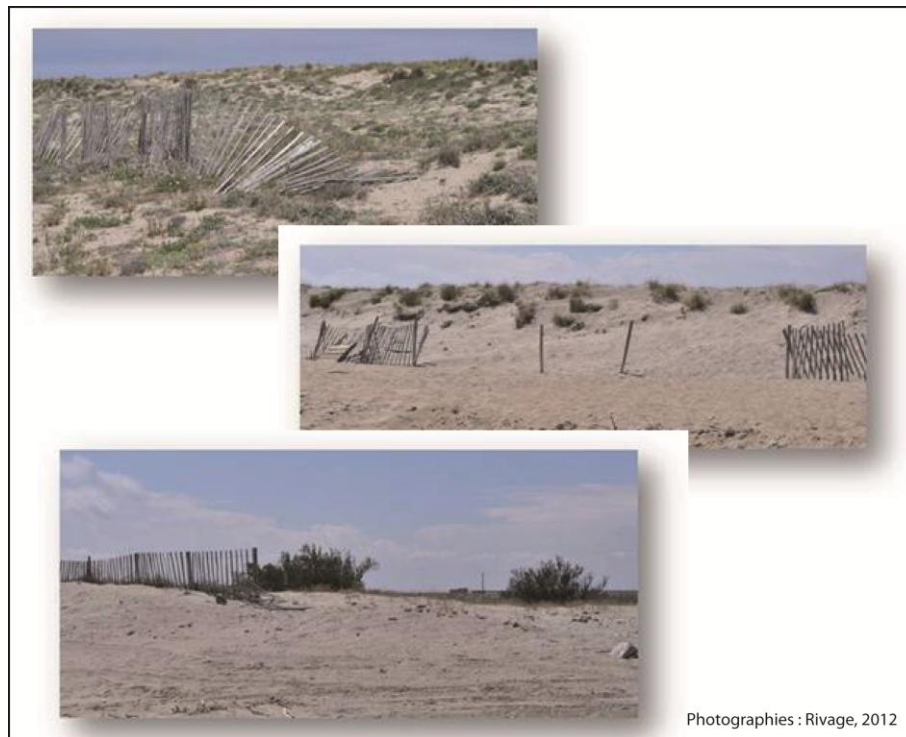
Figure 8 : Les aménagements dégradés au Mouret en 2012
