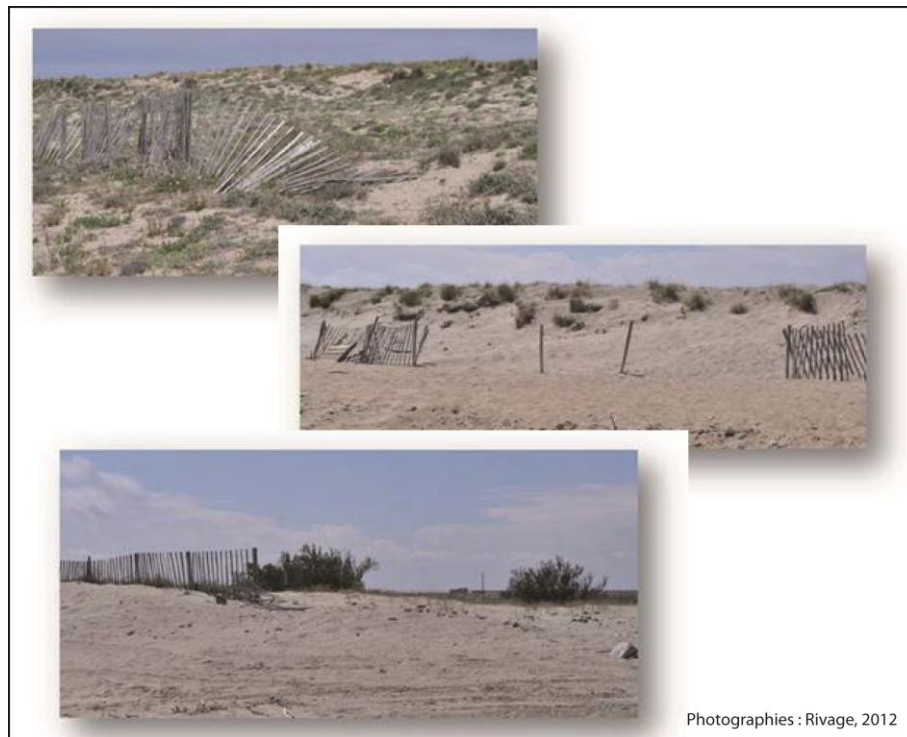
Figure 8 : Les aménagements dégradés au Mouret en 2012
