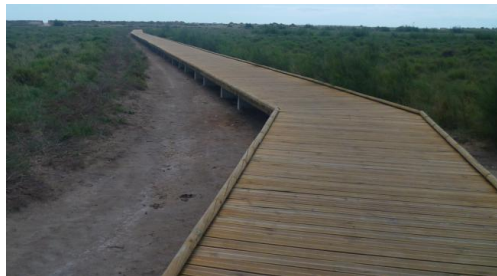
Photographie 4 : Passerelle en caillebotis sur pilotis entre la dune bordière et le parking du Forum à Vendres en 2011
