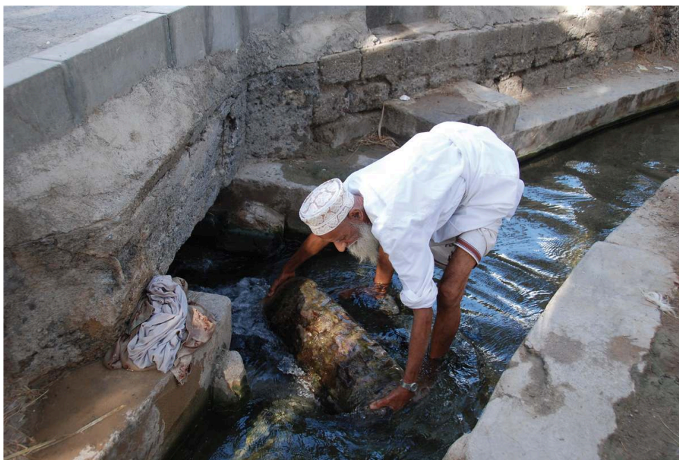
Figure 7. Un irrigant déplace une porte de vanne
