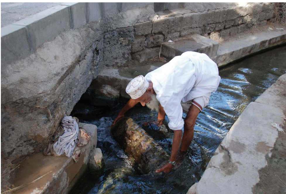
Figure 7. Un irrigant déplace une porte de vanne
