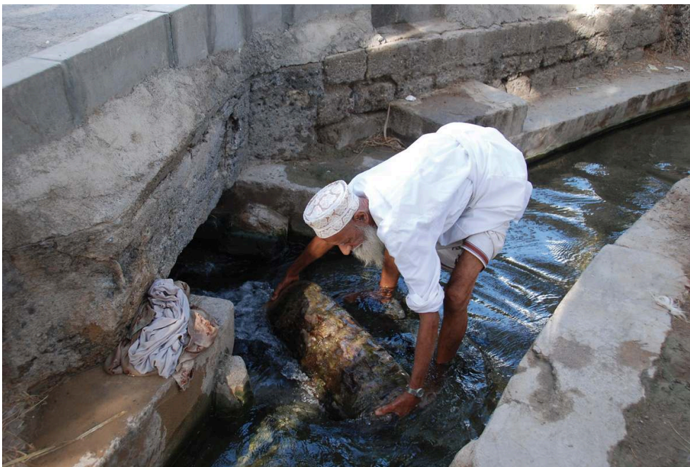
Figure 7. Un irrigant déplace une porte de vanne
