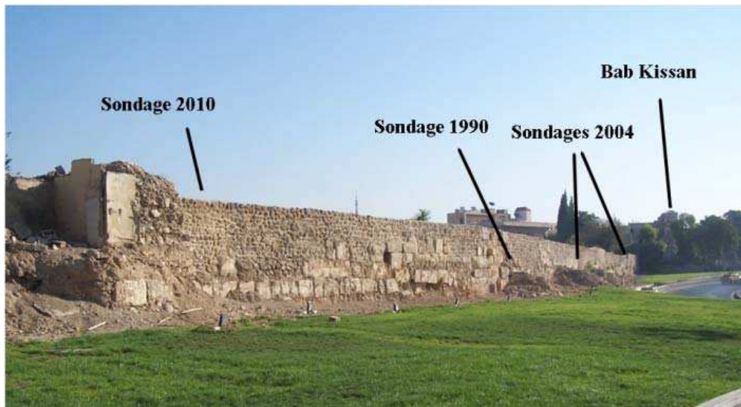
Figure 3 : Localisation des sondages archéologiques sur la muraille sud de la vieille ville, à proximité de Bab Kissan.
