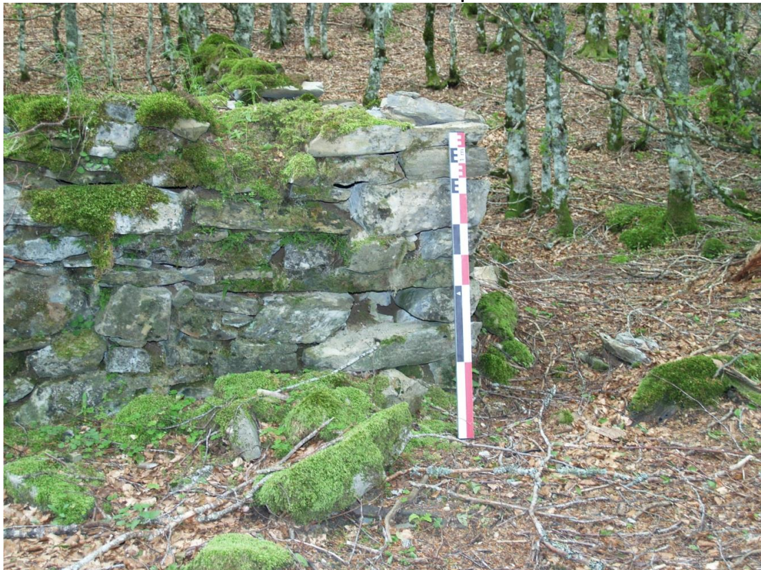
Cliché 4 : vue de l'angle sud-ouest de la cabane 52
