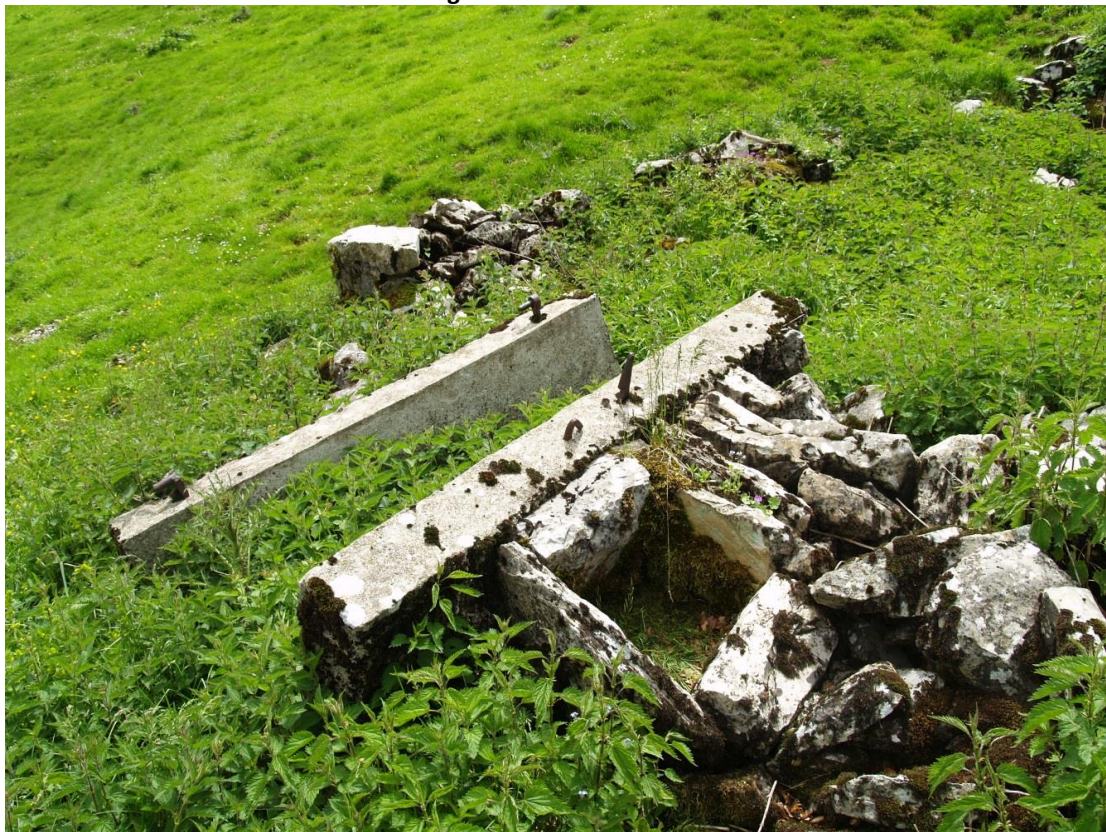
Cliché 54 : entrée de la structure 70
