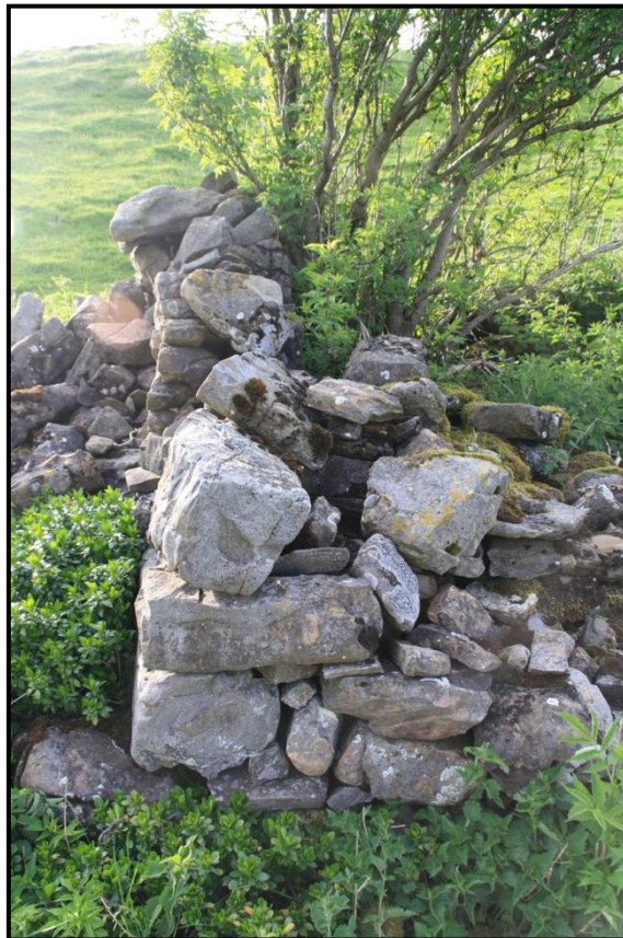
Photographie de la structure 29
