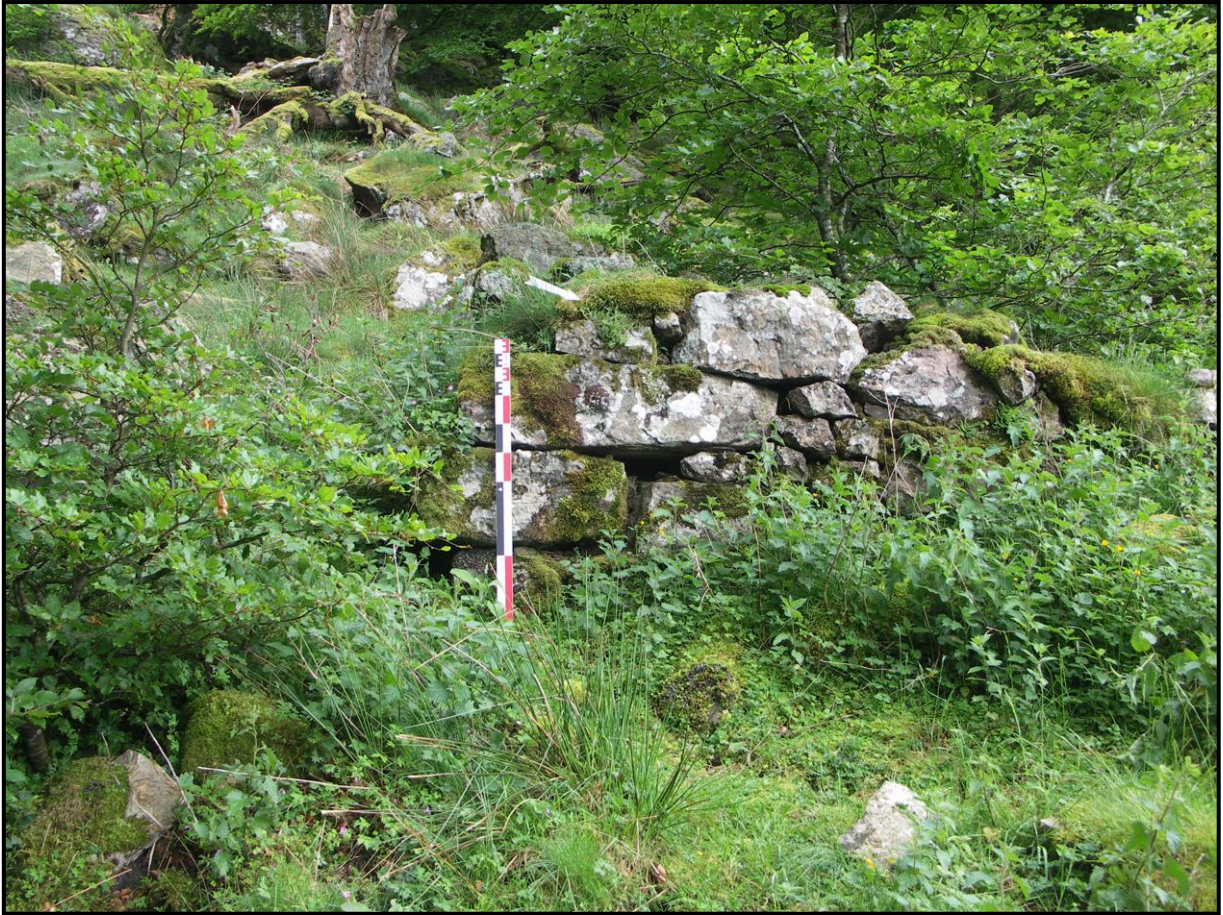
Photographie de la structure 33
