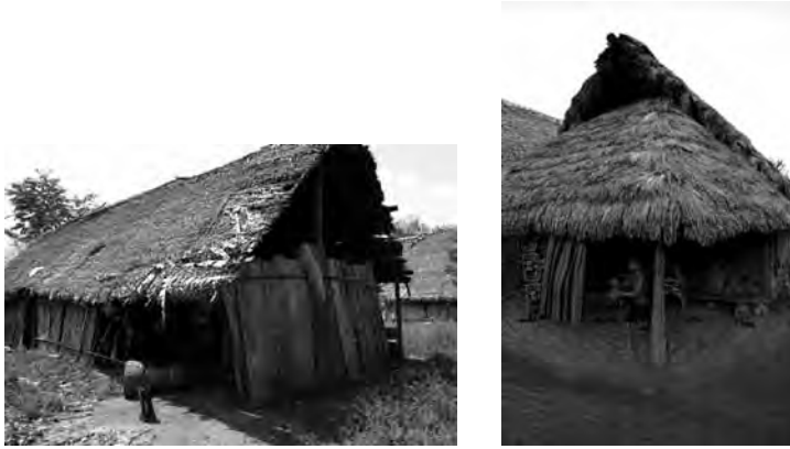
FIG. 32 y 33. Makilakuntiwala, resguardo indígena de Arquía, Chocó (marzo de 2008). La estructura externa de la nega , vivienda de los kunas Fuente: Fotografías del autor
