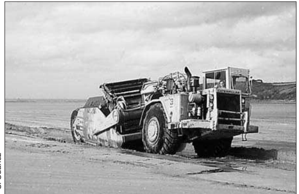
Ouverture du chenal artificiel du Yar à l'aide d'un engin de type "épilucheur".
