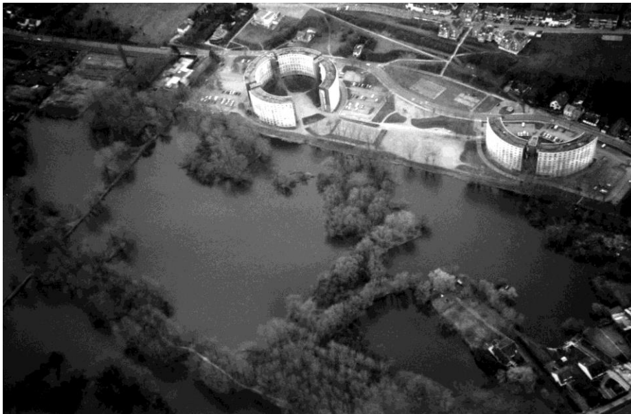
Photo 2 : le marais des Trois Vaches dans la vallée de l'Avre : des étendues aquatiques héritées de l'extraction de la tourbe écornées par les habitats collectifs sur remblais de Victorine Autier (cl. S. Doumel, 2004)
