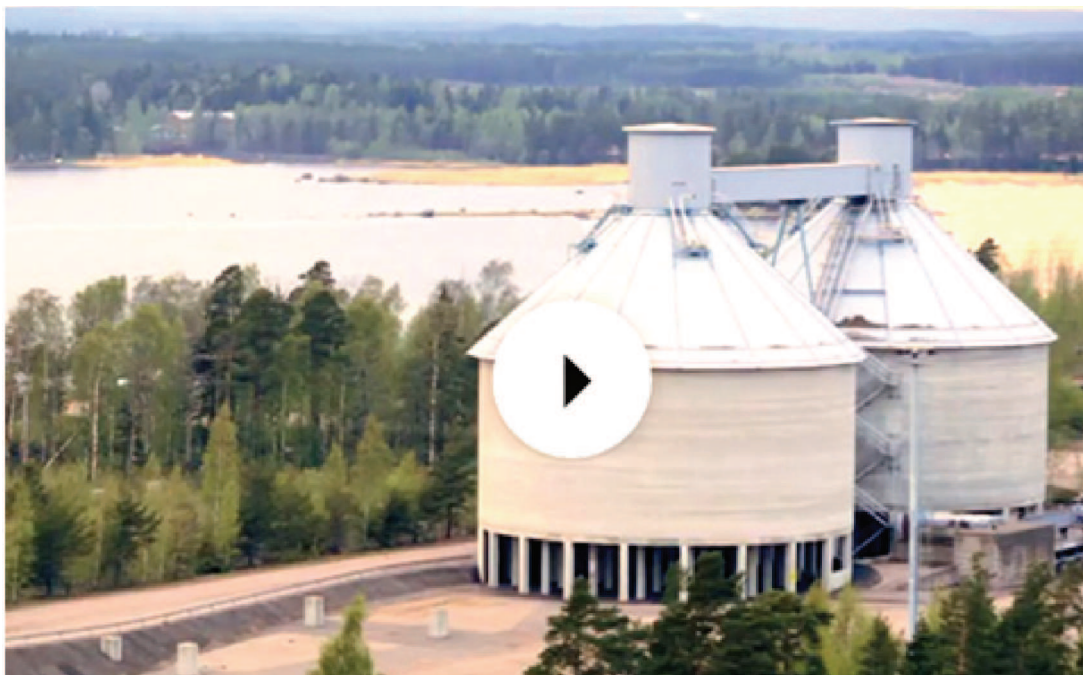
Eléments du système de refroidissement à base d'eau de mer du datacentre de Google à Hamina (Finlande, vers 2010). Cliché extrait du site Google 82
