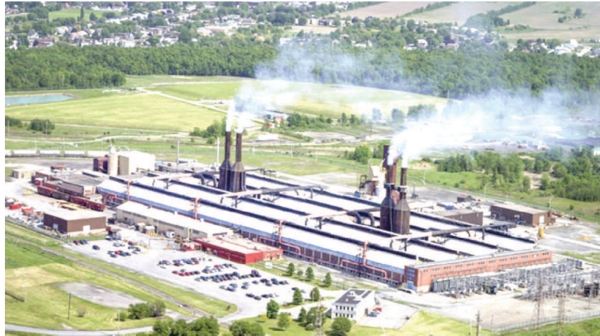
L'usine d'électrolyse de Rio Tinto Alcan avant sa réaffectation en datacentre. Source : OVH 59
