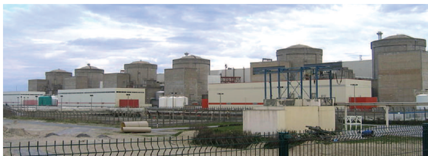
La centrale nucléaire de Gravelines (2008) 48
