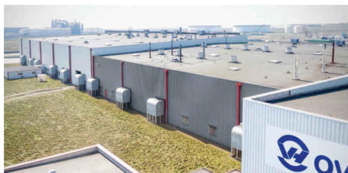
Le datacentre d'OVH de Gravelines Cliché OVH (2013) 44
