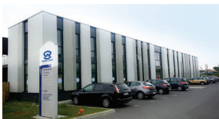
Locaux brestois d'OVH, situés à proximité de l'aéroport Brest-Bretagne Cliché OVH 96
