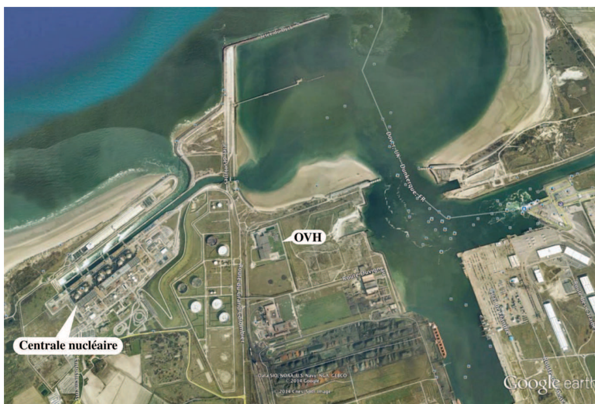
Le site de l'établissement d'OVH à Gravelines Cliché Google Earth (capture 2014)
