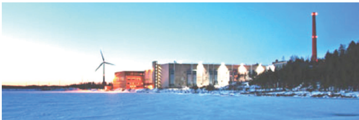
Le site du data centre de Google à Hamina (Finlande, vers 2010). Cliché Google 83
