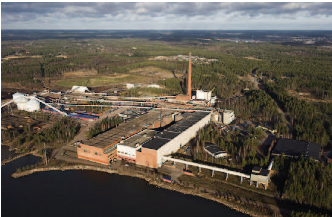
Ancienne usine de papier à Hamina (vers 2007), Finlande Cette usine a été reconvertie en datacentre par Google 81
