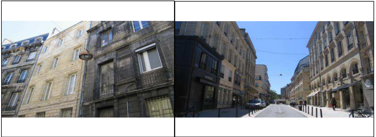
Figure 5: Rues du centre-ville de Bordeaux (photo: V. Kociemba)
