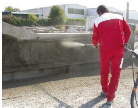
b) Projection mortier voie humide
