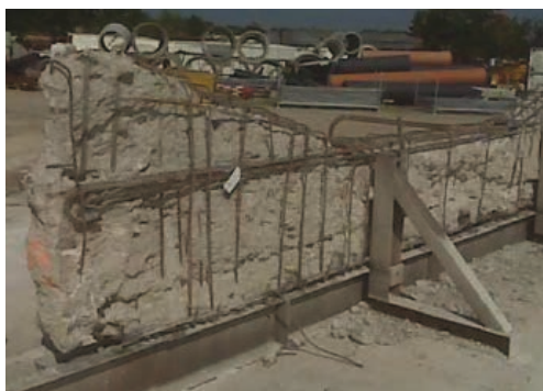
a) Poutre après hydrodémolition
