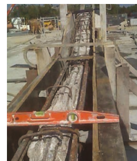
c) Béton coffré
