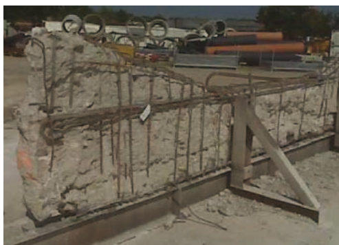
a) Poutre après hydrodémolition
