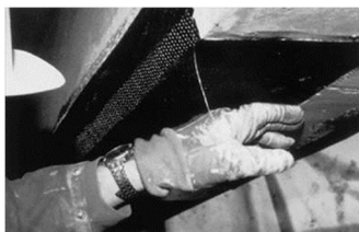
Figure 4. Poutre renforcée par TFC.
