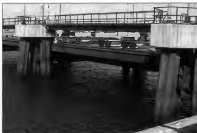
**Photo 3 : Peniche est un port sur la côte portugaise. La structure étudiée ici sert à mettre hors eau les bateaux pour en faire la maintenance. Dans ce cas on s'intéresse à l'état de corrosion de la structure, et aux risques induits par la dégradation de l'ouvrage à plus ou moins long terme.**
