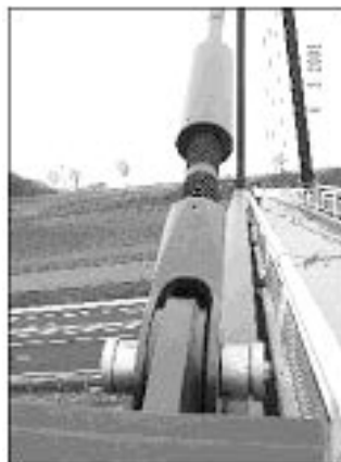
Figure 11. Dispositif d’ancrage bas réglable
