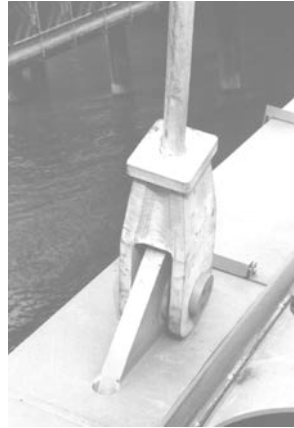
Figure 8. Dispositif d'ancrage à chape
