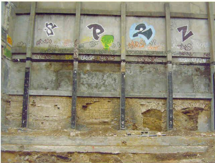
Fig. 4 : 19 rue l'Empereur, mur mitoyen, salle basse (gauche) et fondation (droite)
