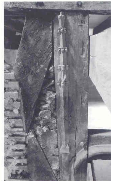
Fig. 12 : 85 rue de la Charpenterie, demi-croisée du deuxième étage, sommet du pinacle gauche
