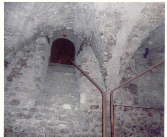
Fig. 5 : salle basse située sous l'église Saint-Donatien
