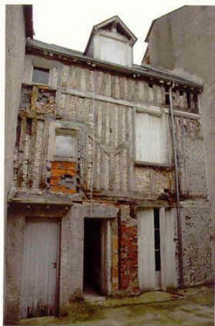
Fig. 9 : 85 rue de la Charpenterie, façade sur cour
