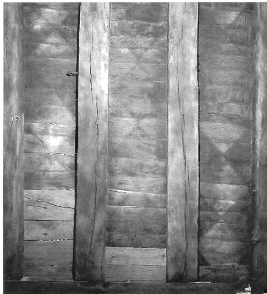
Fig. 16 : Maison 9 rue des Trois-Maries/272 rue de Bourgogne, salle du rez-de-chaussée (bâtiment 2) : plafond avec motifs peints de losanges alternés noirs et blancs (C. Alix).
