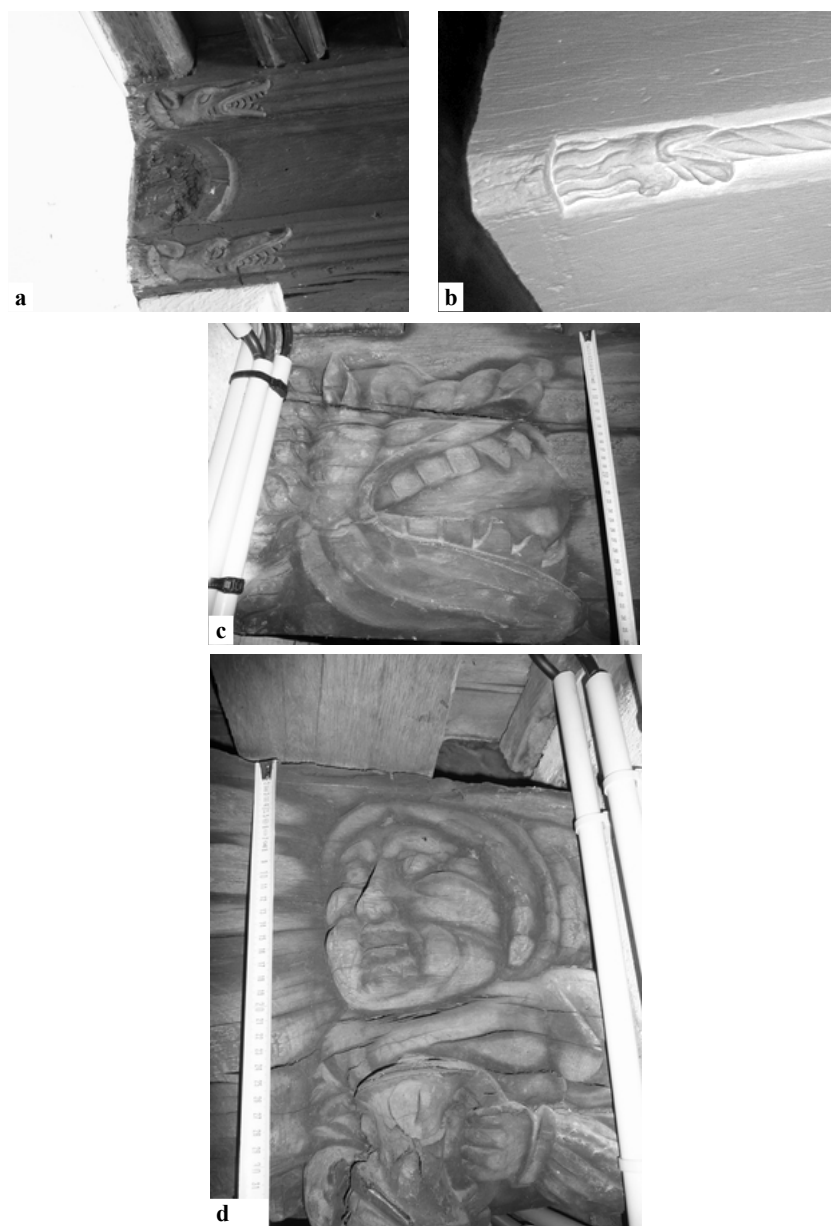
Figure 18 : Exemples de plafonds à poutres engoulées. a : hôtel de Guillaume Toutin, 26 rue Notre-Dame-Recouvrance (vers 1534-1540), bâtiment est, 1 er étage : demi-disque formant médaillon sur la poutre, solives sculptées de fleurs de lys et de dauphins. b : hôtel du quartier cathédrale, 22 rue Saint-Étienne : poutre occidentale du 1 er étage : engoulant à l'envers. c et d : maison 12 rue Notre-Dame-de-Recouvrance, bâtiment sur cour, rez-de-chaussée : grand engoulant faisant face à un personnage en buste. Cl. Clément Alix.
