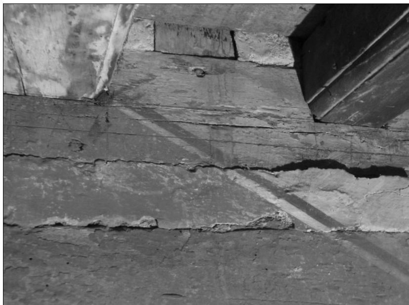
Figure 8 : Corps de bâtiment 2 (BAT 2), plafond du rez-de-chaussée : décor peint sur une poutre maîtresse le long de la 2 e volée de l'escalier rampe-sur-rampe. Cl. Clément Alix.
