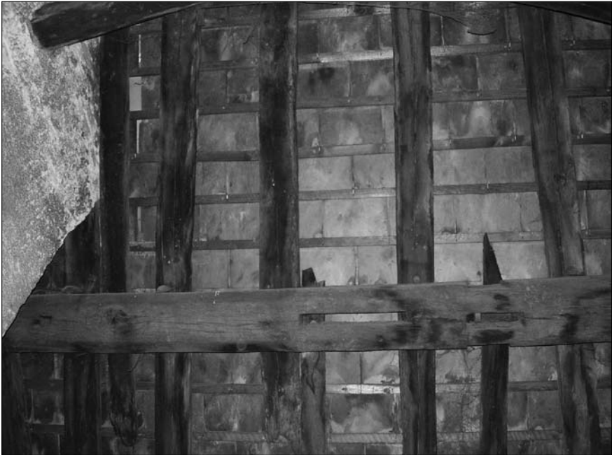
Figure 8 Corps de bâtiment 2 (BAT 2), comble, versant nord : ancien poinçon chanfreiné en remploi comme panne. Cl. Clément Alix.
